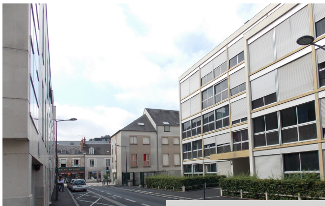
Façade côté rue avant travaux
