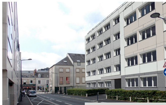
Façade côté rue après travaux
