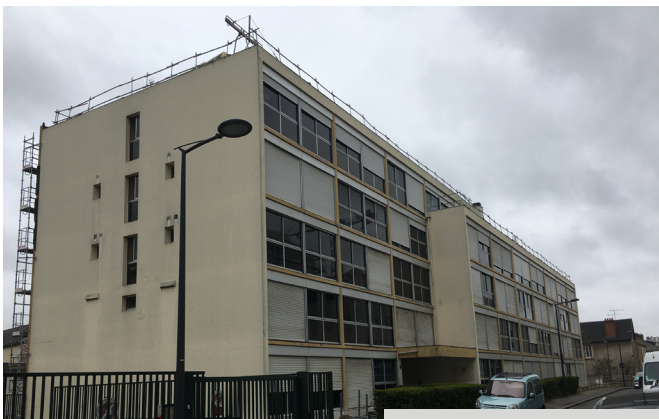
Résidence avant travaux
